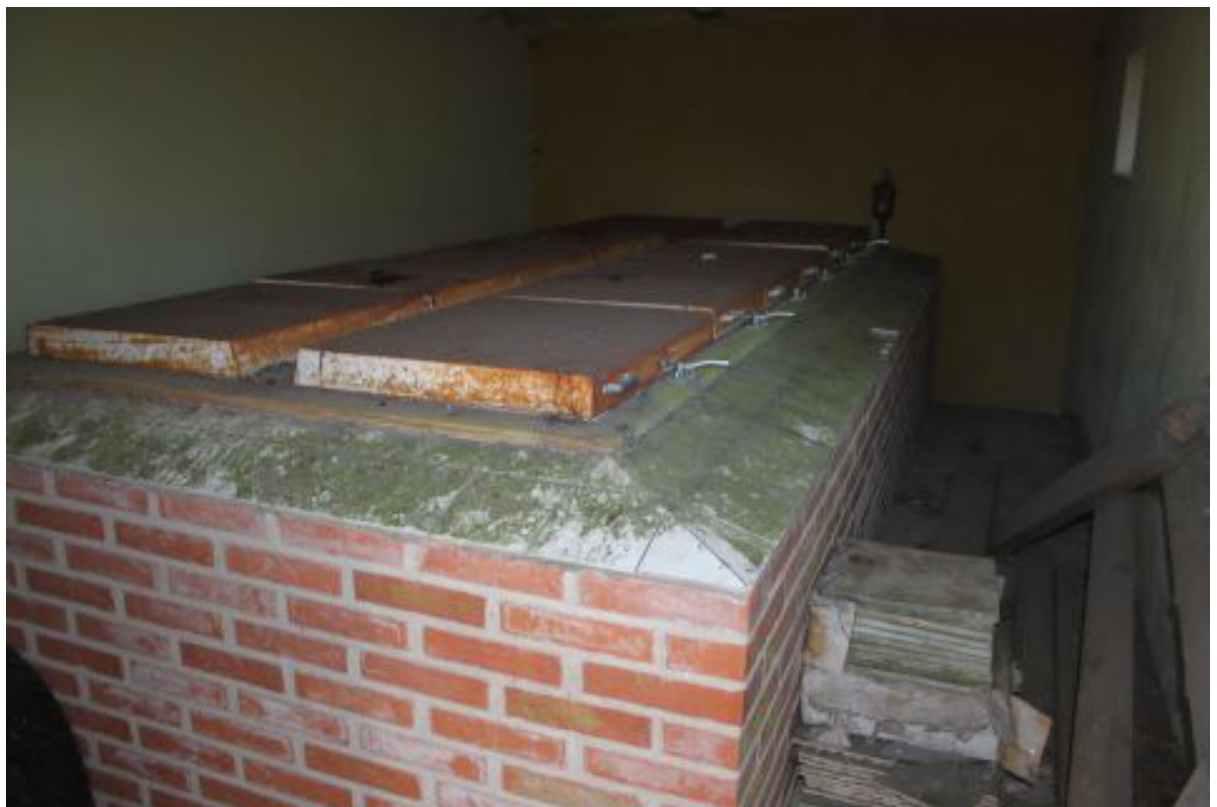
Her et kig ind i Gåser Frysehus i marts 2021, hvor boksene til de 12 medlemmer stadig står. På fotoet ses de 6 beslag til åbning af boksene i højre side, og der er et tilsvarende antal i modsatte side. Man fornemmer næsten, at frysehuset står som da det blev taget ud af drift for over 40 år siden. Foto: Klem Thomsen.
