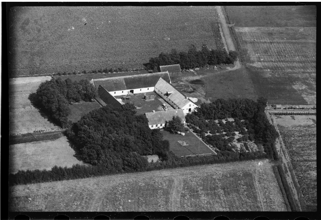
Østergaard fotograferet fra luften i 1946. Men husene er sandsynligvis de huse, som blev bygget af Sigfred Knudsen inden Første Verdenskrig. Vi ser også den store have med frugttræer og – buske som beskrevet af sønnen John (Johannes). Det må have været et meget stort projekt og betydet store lån og megen gæld, og man forstår godt Fransines og børnenes sorg ved at forlade stedet, so de selv har bygget op.
