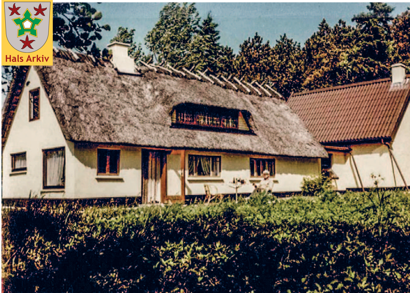
Heden 30 fotograferet før branden i 1985. Billedet er fra kommunal sag, hvor der ansøges om tilladelse til genopførelse. Privat foto.
